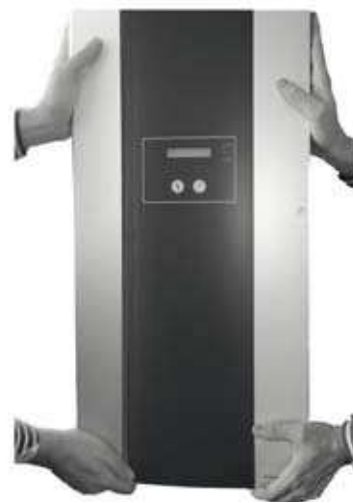
Bild 8: Wechselrichter aufstellen
