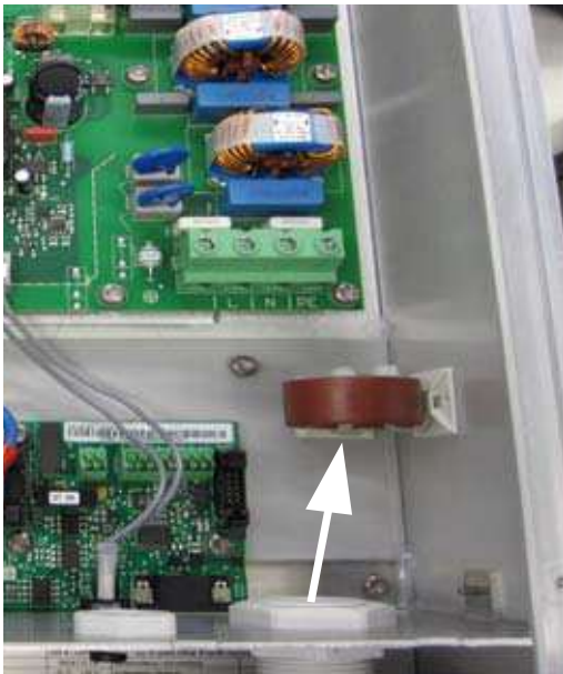
Bild 13: AC-Leitungen in Anschlussbereich einführen
